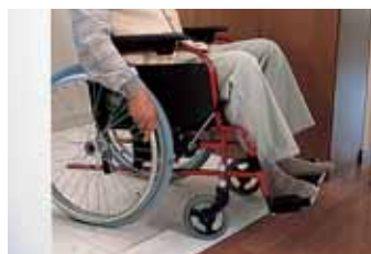
段差のない玄関上がり框(マンション)
