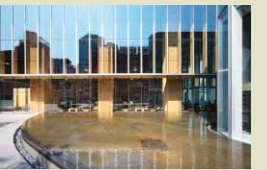
光触媒浄水機を導入した「赤坂Bizタワー」の水景
