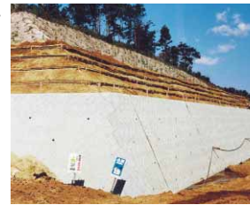
1980年 (ポット苗施工中)
