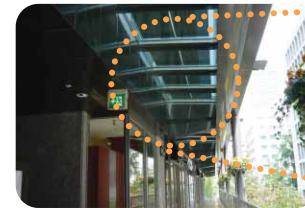
南側2階デッキ
