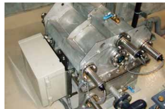
東京ミッドタウンに設置されている「丸型光触媒浄水機」
