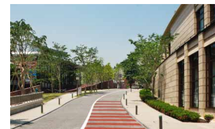
赤坂サカスの浸透性舗装
