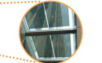
太陽光発電ができるガラスの屋根
