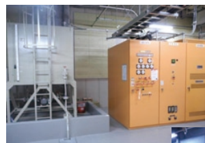
燃料タンク(一部)
