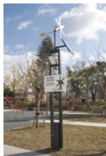
小型太陽光発電機付き 風力発電機
