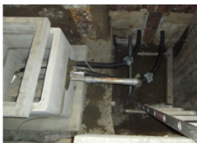
井戸掘削工事(日本橋三井タワー)
