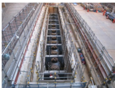
オイルタンク増設工事 (霞が関ビルディング)
