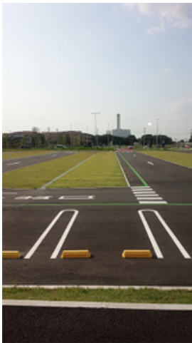
芝生の緑化ブロックを設置した駐車場
