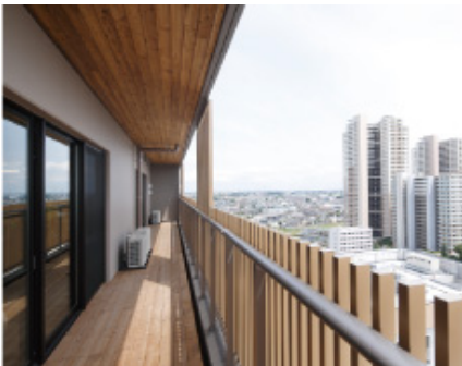
バルコニーの床と天井のサーモウッド材 (柏の葉スマートシティ ゲート スクエアホテル&レジデンス棟)
