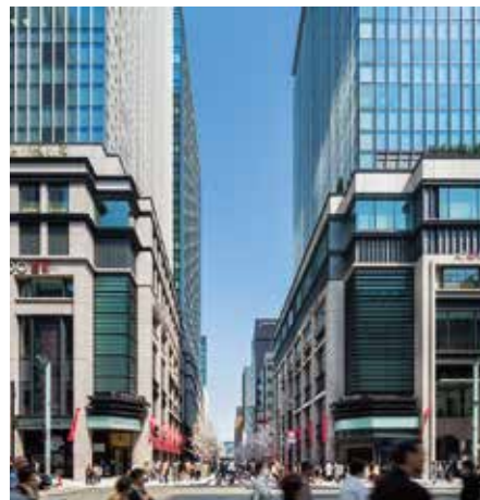
「COREDO室町1」「COREDO室町3」(東京都中央区)
