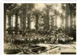
建築中の様子
