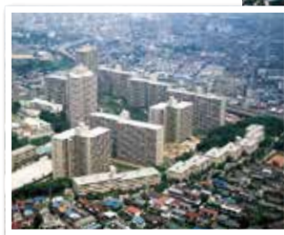
竣工当時の様子
