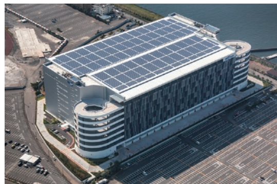
「MFLP船橋I」の太陽光発電パネル
