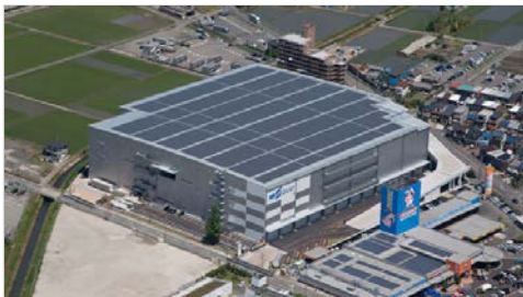
「MFLP福沢」の太陽光発電パネル（発電能力約1,500kW）
