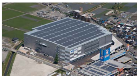
「MFLP福沢」の太陽光発電パネル（発電能力約1,500kW）
