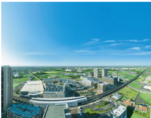
「柏の葉スマートシティ」(千葉県柏市)
