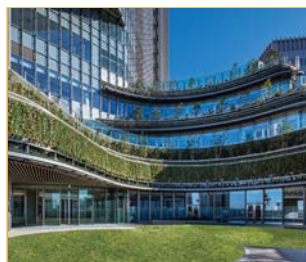
▶ 壁面・屋上緑化
