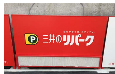
『「三井のリパーク」広島猿猴橋町第3駐車場』に設置した光触媒フィルター付きの排ガスパネル
