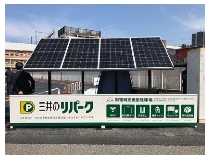
「三井のリパーク」みなとまち新潟駐車場の ハイブリッドソーラーシステムの太陽光発電パネル
