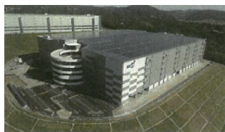
「MFLP 茨木」の太陽光発電パネル (発電能力約 2,000kW)
