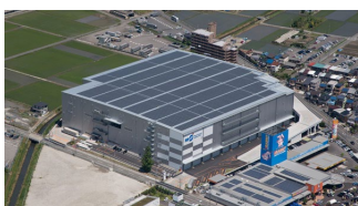
「MFLP 稲沢」の太陽光発電パネル (発電能力約 1,500kW)
