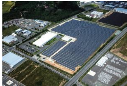
八戸太陽光発電所
