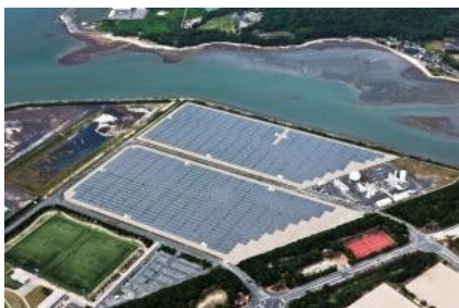
山陽小野田太陽光発電所
