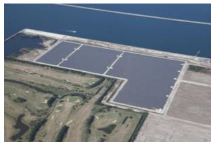
大分太陽光発電所
