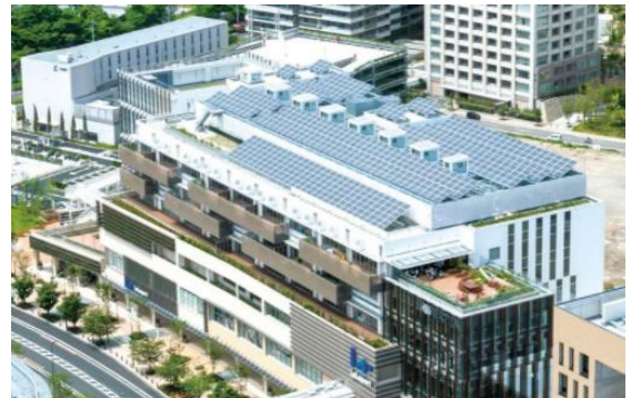
ららぽーと柏の葉屋上太陽光パネル
