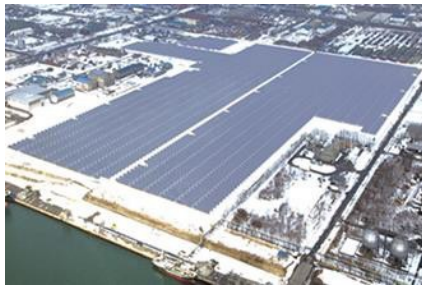
苫小牧太陽光発電所
