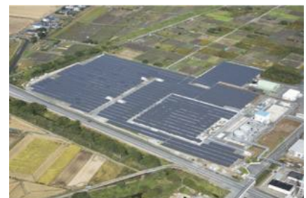
大牟田太陽光発電所
