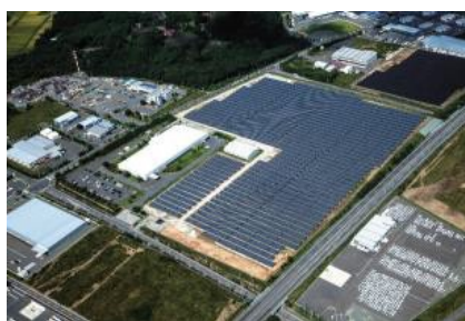
八戸太陽光発電所
