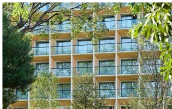
三井ガーデンホテル神宮外苑 (日光を遮るバルコニーを採用し空調効率を向上)
