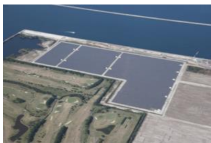
大分太陽光発電所
