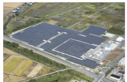
大牟田太陽光発電所
