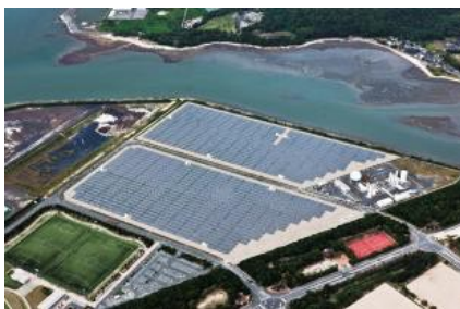
山陽小野田太陽光発電所
