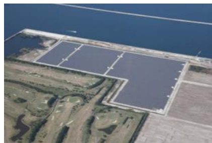
大分太陽光発電所
