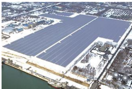
苫小牧太陽光発電所
