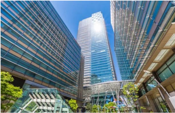
既存施設においては計画的なリニューアルを行ない環境性能の向上を図る
