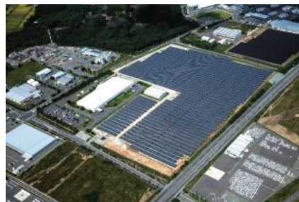
八戸太陽光発電所
