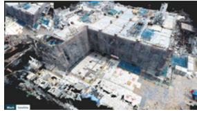
撮影した写真データをつなぎ3Dデータを作成
