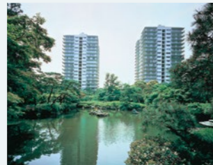
三田綱町パークマンション竣工 (1971年)
