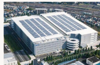
太陽光発電設備の導入 MFLP日野では発電容量約2MWの太陽光発電設備を導入したほか、全館LED照明の採用など省エネ性能を高めています
