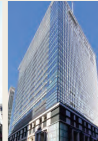
室町古河三井ビルディング
