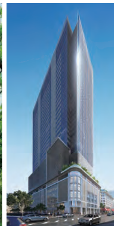
日本橋高島屋三井ビルディング
