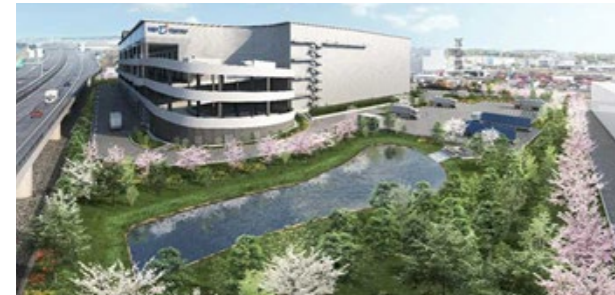
三井不動産ロジスティクスパーク海老名I (ZEB認証取得予定) 業界初となるCO 2 排出量実質ゼロの「グリーンエネルギー倉庫」。屋根には太陽光発電設備を設置しオンサイトでの発電・供給を実現。グリーン電力提供サービスも展開し、入居企業の脱炭素化もサポート。
