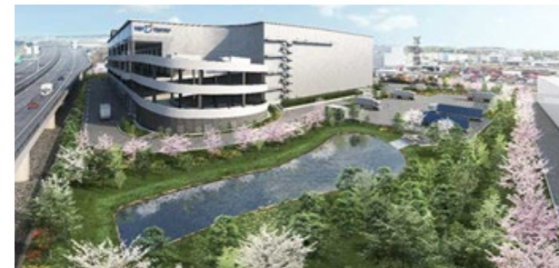
三井不動産ロジスティクスパーク海老名I (ZEB認証取得予定) 業界初となるCO 2 排出量実質ゼロの「グリーンエネルギー倉庫」。屋根には太陽光発電設備を設置しオンサイトでの発電・供給を実現。グリーン電力提供サービスも展開し、入居企業の脱炭素化もサポート。
