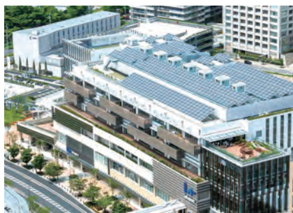
太陽光パネル
