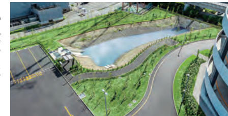
景観に配慮した雨水貯留池
