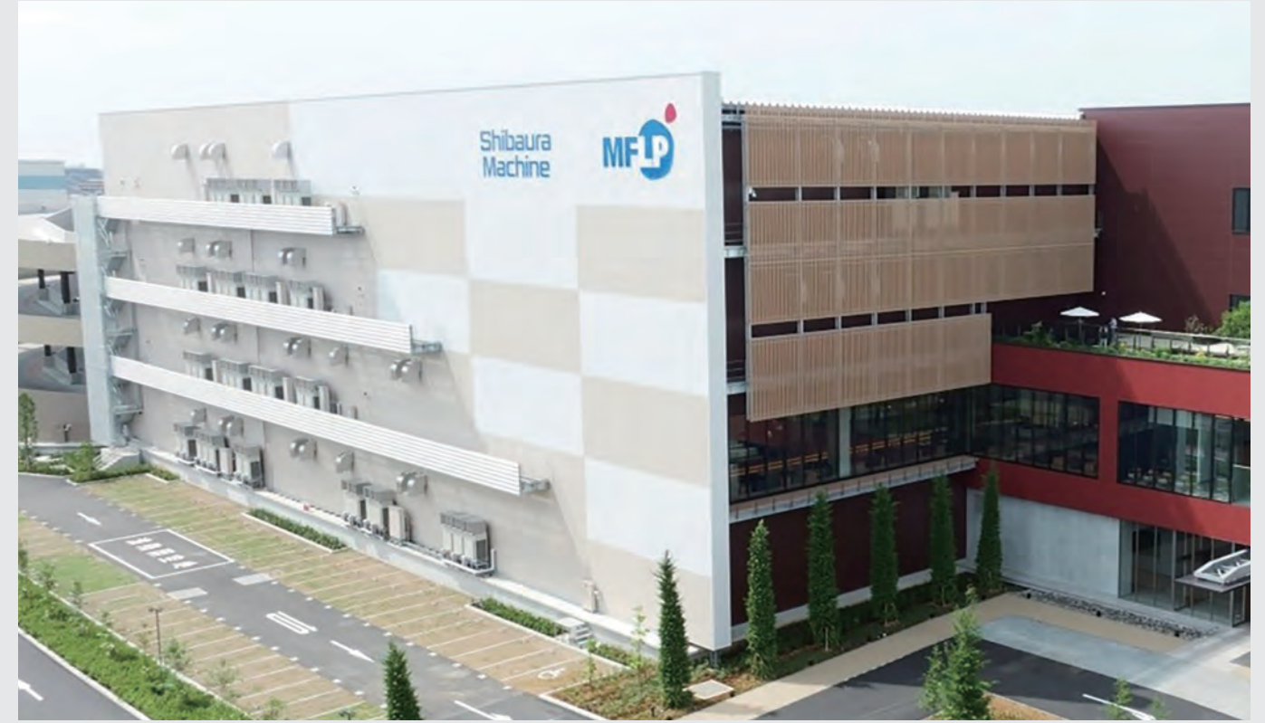
「三井不動産ロジスティクスパーク(MFLP)座間」外観(神奈川県座間市)
