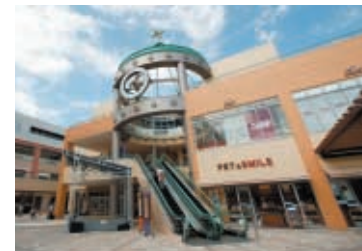
ステラタウン (平成16年4月オープン)
