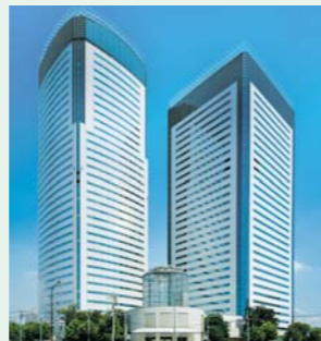
豊洲センタービル(写真左) / 豊洲センタービルアネックス(写真右)
