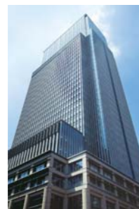
日本橋三井タワー
