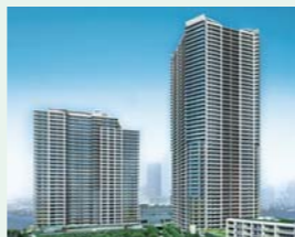
アーバンドック パークシティ豊洲 (平成20年3月竣工予定)
