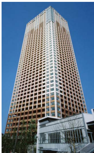
芝浦アイランド エアタワー (平成19年3月竣工)
