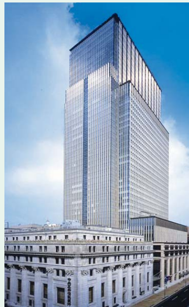
日本橋三井タワー
