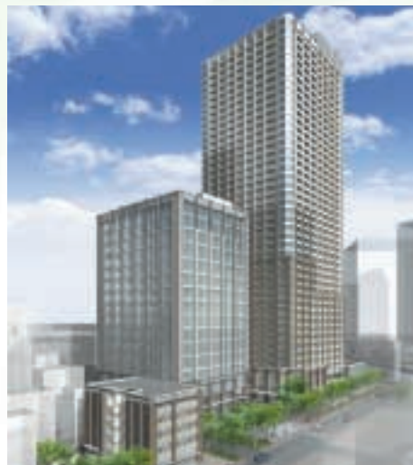
東五反田二丁目第2地区第一種市街地再開発事業 (平成21年10月全体竣工予定) 完成予想図
