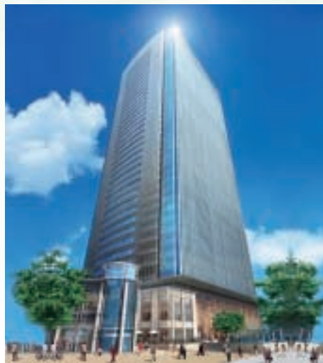
赤坂五丁目TBS開発計画 (平成20年1月竣工予定) 完成予想図
