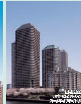
運用受託物件 リバーサイドレジデンス (株)三井不動産アコモデーションファンドマネジメント
