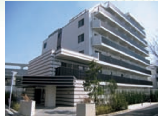
パークアクセス蒲田壱番館 (平成21年3月竣工)
