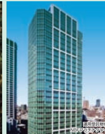
運用受託物件 NBFプラチナタワー 日本ビルファンドマネジメント(株)
