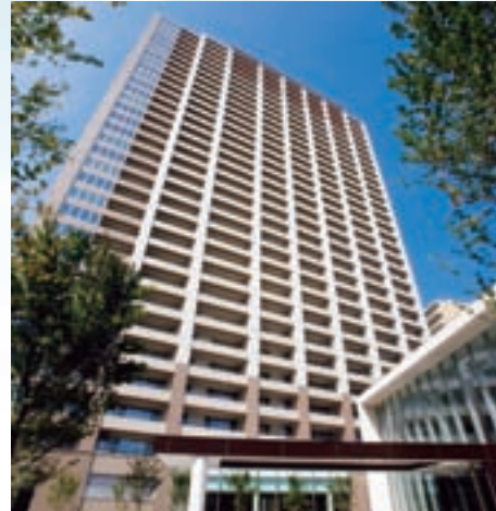
ミッドブレイス仙台タワー&レジデンス (平成21年9月竣工)
