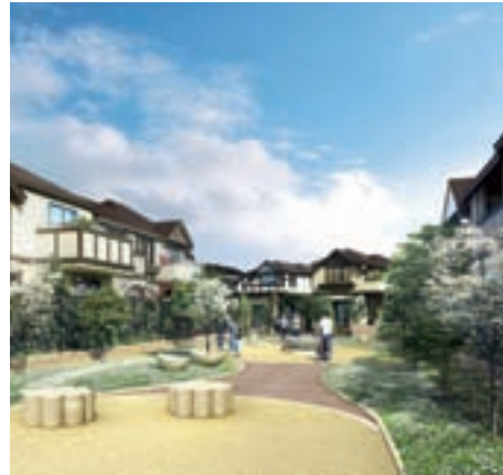
ファインコート流山おおたかの森 (平成22年5月第1期竣工) 完成予想図
