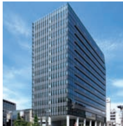
名古屋三井ビルディング新館 (平成23年6月竣工)
