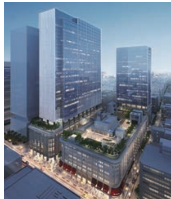
日本橋二丁目地区第一種市街地再開発事業 (2018年度竣工予定/東京都中央区) イメージパース
