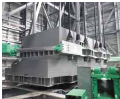
「新宿三井ビルディング」TMD完成写真(東京都新宿区)
