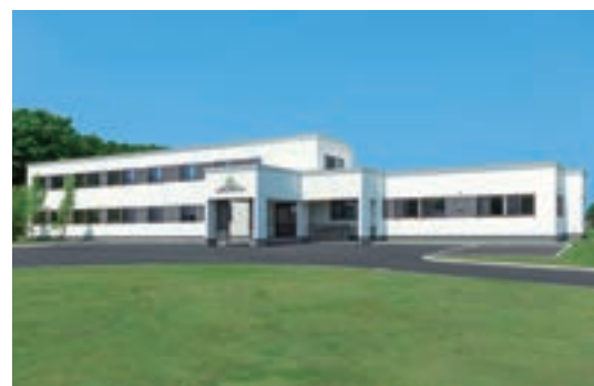
「恵庭コミュニティービレッジ ピッセ」 サービス付き高齢者向け住宅棟(北海道恵庭市)
