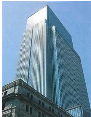
日本橋三井タワー
