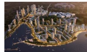
大連ソフトウェアパーク2期 ・遼寧省大連市 ・2014年10月全体竣工 ・住宅2,000戸/商業施設床面積47,000㎡
