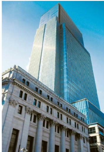
日本橋三井タワー (2005)
