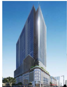
日本橋高島屋三井ビルディング
