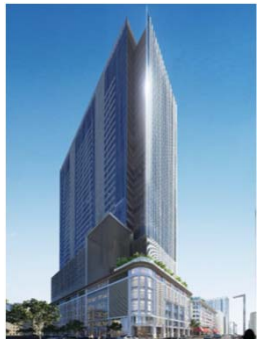
日本橋高島屋三井ビルディング
