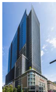
日本橋高島屋三井ビルディング
