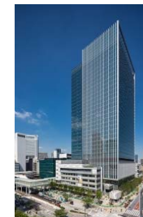
msb Tamachi (田町ステーションタワー-S)
