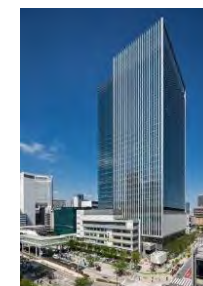
msb Tamachi (田町ステーションタワー-S)
