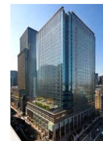
日本橋室町三井タワー
