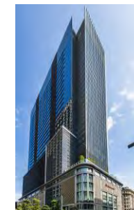
日本橋高島屋三井ビルディング
