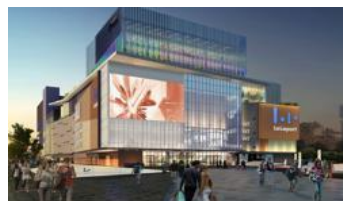
上海蓮花路駅ビル商業施設
