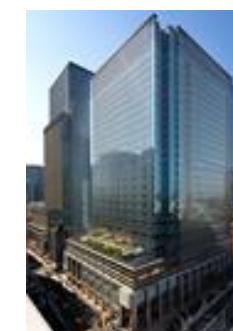
日本橋室町三井タワー
