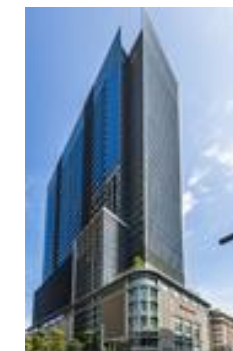
日本橋高島屋 三井ビルディング
