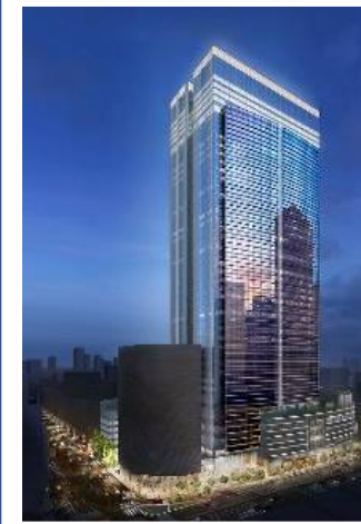
八重洲二丁目北地区 (2022年8月 竣工予定)
