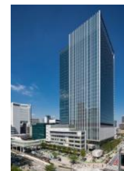
msb Tamachi (田町ステーションタワー-S)
