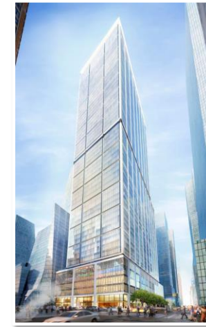
50ハドソンヤード (2022年 竣工予定)
