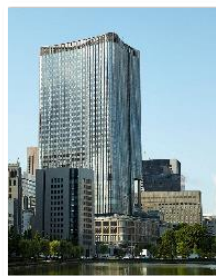
東京ミッドタウン日比谷 (2018年 竣工)
