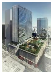
日本橋高島屋三井ビルディング(2018年 竣工)
