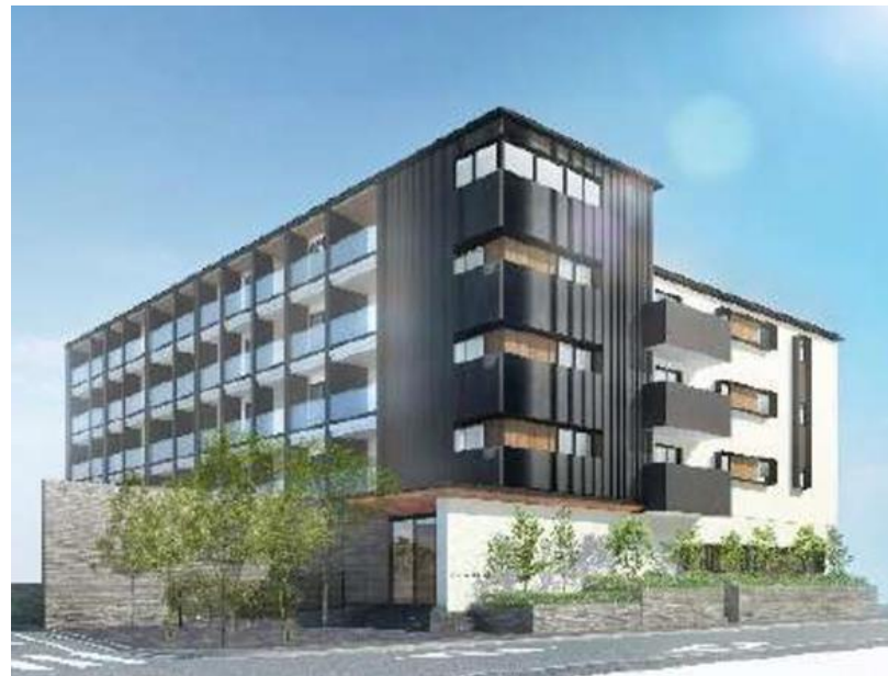
木造マンション
