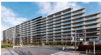
「パークホームズ板橋蓮根 二番街」 (東京都板橋区)
