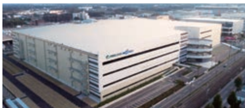
「MFLPプロロジスパーク川越」 (埼玉県川越市)
