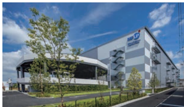
「三井不動産ロジスティクスパーク大阪Ⅰ」 (大阪府大阪市)
