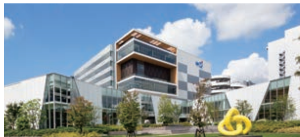
「三井不動産ロジスティクスパーク船橋Ⅲ」 (千葉県船橋市)
