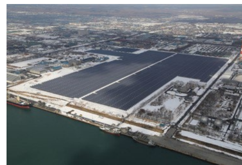
苫小牧太陽光発電所
