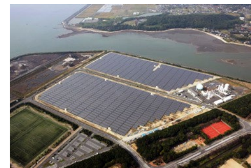
八戸太陽光発電所
